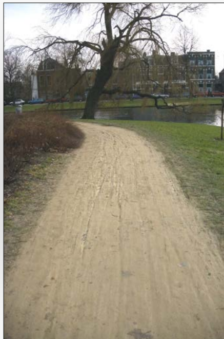
Pad van gralux met spoorvorming
