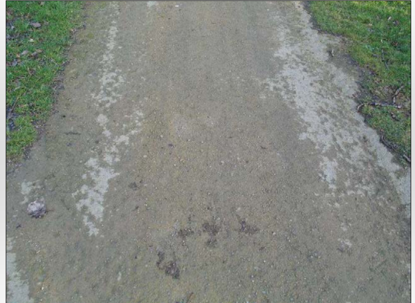
Close-up van een pad in het Trigonpark, het gralux is vermengd met stabicol
